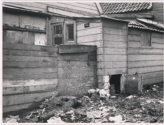
Fig. 1.1: Het tonnenstelsel: een ton onder de zitting in een huisje Zaandam 1959. In 1874 werd in Zaandam, net als in veel andere gemeenten in de tweede helft van de 19de eeuw, het tonnenstelsel ingevoerd; het bleef hier tot ver in de 20 e eeuw gehandhaafd.
